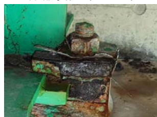
図-6 Rc-III 塗装系の減肉・ 断面欠損事例
