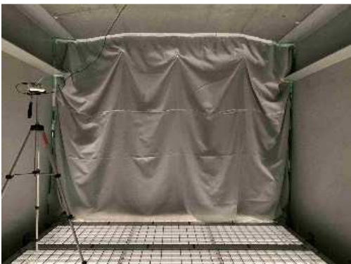
図-4 桁間点検足場内（暗幕内）の状況
