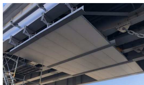
図-1 試験橋梁への取付状況
