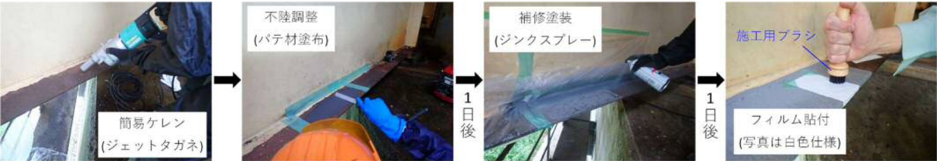
図 2 試験施工状況（A 橋）
