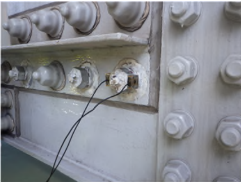
写真- 3 ボルト軸力測定状況
