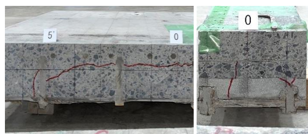
a) 走行軸中央部 b) かすがい継手部 写真1 走行試験後の断面 (6mm鋼板)
