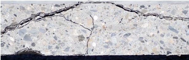
写真-2 載荷点近傍のひび割れ状況 (供試体-2：橋軸直角方向断面)
