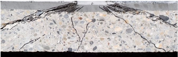
写真-3 載荷点近傍のひび割れ状況 (供試体-3：橋軸直角方向断面)
