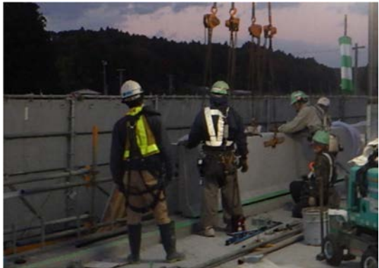
写真-1 アンカータイプ PCa 壁高欄設置状況
