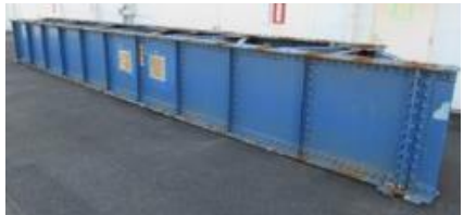
図1 撤去後の鋼桁の例（鋼桁C）
