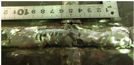
(b) 補修溶接後
