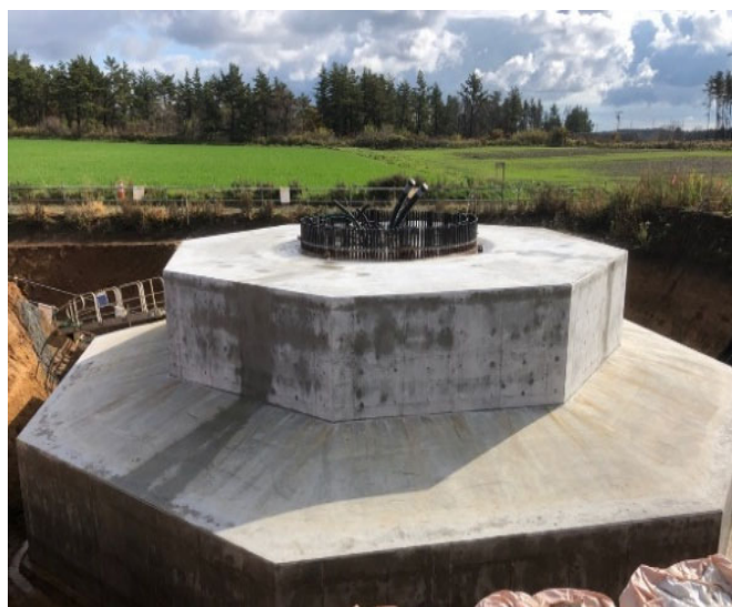
図3 基礎躯体 完成時全景
