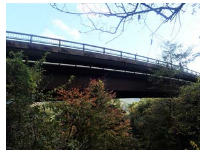
写真-1 対象橋梁外観
