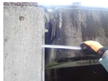
写真-2 A2橋台遊間
