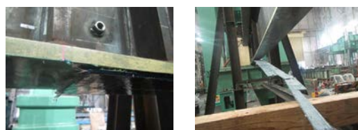
1) シートの破断 2) シートの剥離 図-5 CFRP シートの破壊性状
