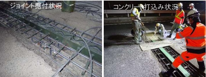
写真-2 橋梁ジョイント（簡易鋼製タイプ）
