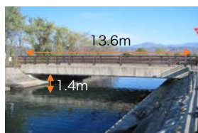
図-4 撮影した橋梁
