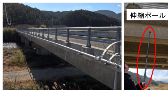
(a) 橋梁 A の全体像 (b) 伸縮ポール 図-2 橋梁 A の撮影風景
