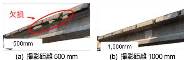
(a) 撮影距離 500 mm (b) 撮影距離 1000 mm 図-6 解体橋梁桁 3D モデル
