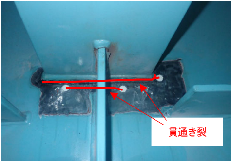
写真-4 ストップホール施工状況 (NG3-S12)
