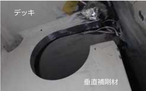
写真1 施工後のσ形切欠き
