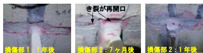
写真2 ICR 処理後のき裂閉口確認 (PT)
