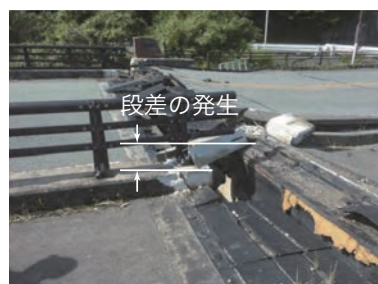
写真1 橋梁の被災事例1)
