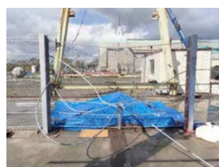
(a) 間隔保持材の車道側への飛散
