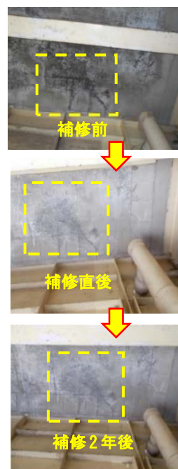
写真-1 床版下面状況
