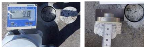
写真-2 付着強度試験状況
