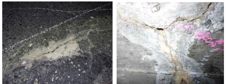
写真-1 舗装および床版下面のひび割れ損傷
