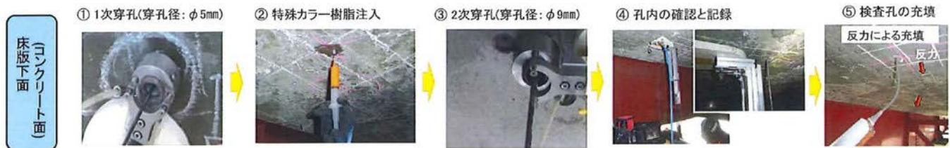
写真-2 シングルアイ工法における調査手順
