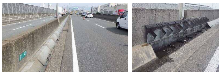
写真-1 鋼製排水溝
