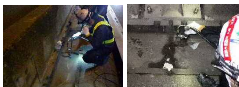
写真-6 STTG 材注入
