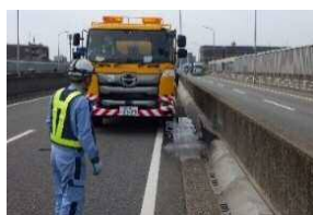
写真-7 散水確認
