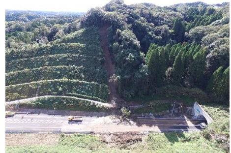
写真-1 災害直後の状況 (UAV撮影)
