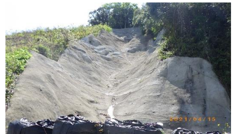
写真-2 応急復旧の状況(R2.4)
