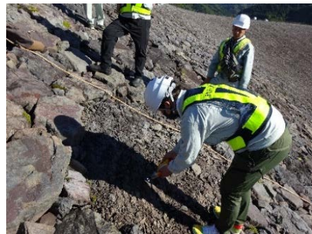
図-1 リップラップ材現地調査状況
