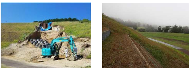
図1 左:復旧工事(2020.8) 右:復旧後(2021.8)
