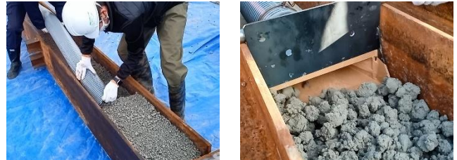
図3 吸引能力確認状況
