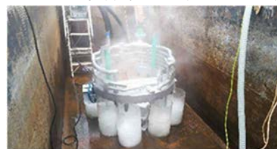
図-6 製作した噴射リングの性能確認
