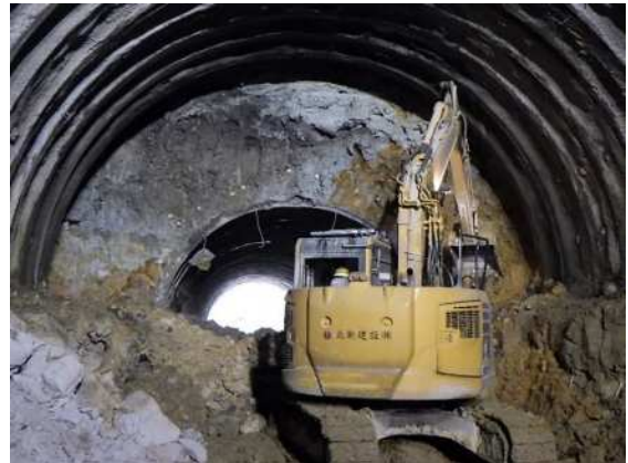
写真-3 作業床の設置
