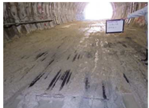
写真-4. 敷鉄板による泥濘化対策
