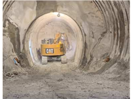
写真-1. 掘削状況 (ツインヘッド)
