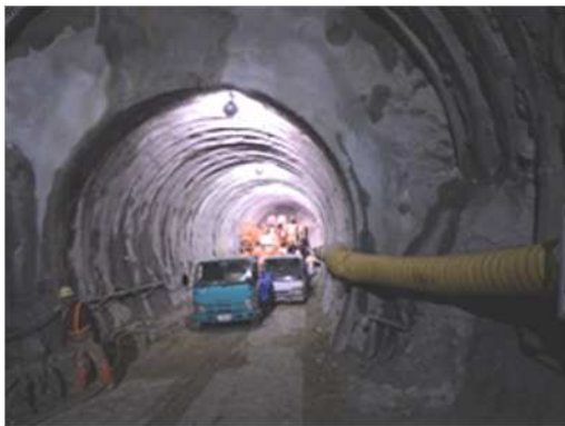
写真-2. ロックボルト施工状況 (2B2B 全油圧ジャンボ)
