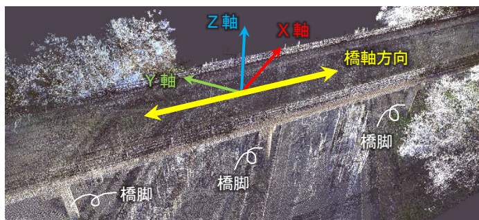
図1 点群データの座標軸と橋軸方向
