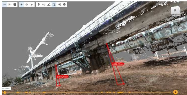
図3 河川橋りょうの3D点群での河床高さ測定
