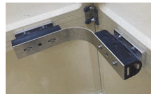
写真-1 制振装置取り付け時
