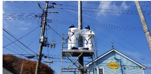
写真.2 注入時の様子（最下部より7m位置）
