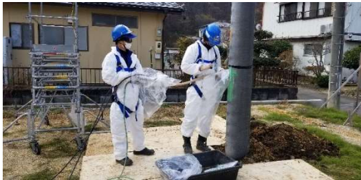
写真.1 注入時の様子（最下部より3m位置）
