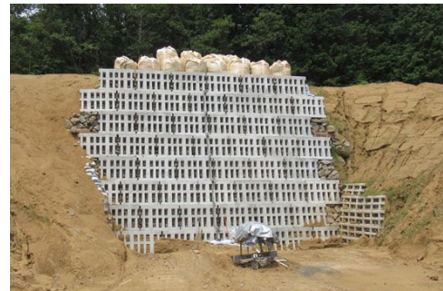
写真-1 ガンロック枠を用いた切土擁壁の試験施工
