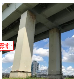
図-2 現地状況写真
