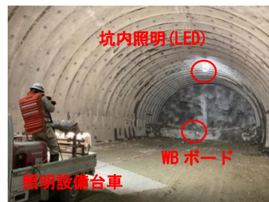
写真-2 切羽撮影状況
