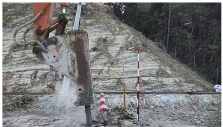
写真-2 施工状況
