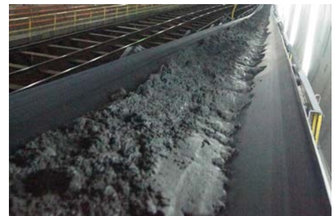
写真-1 ズリ出しベルコン
