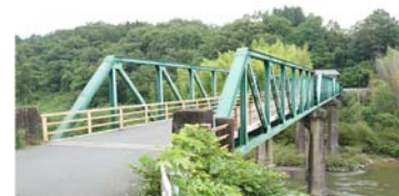
図-1 橋梁の外観
