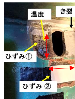
写真-3 FBG センサ設置状況
