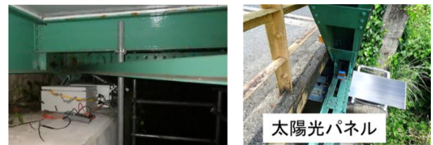
写真-5 システム設置状況
