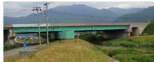
図1 対象橋梁外観
