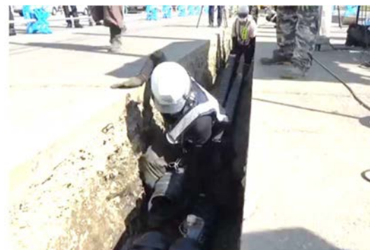
写真-3 角型多条電線管の敷設状況
