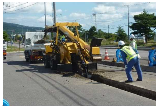
写真-2 トレンチャー掘削状況
