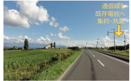
写真-6 地域を象徴するシンボルツリーの眺め（左）を阻害しないよう、通信線を右側の電柱に移設・共架した（美瑛町）
