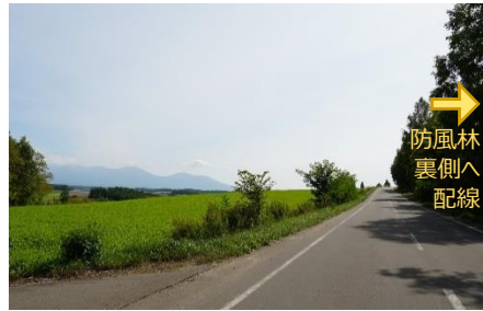
写真-5 新栄の丘（美瑛町）へのアクセス道路の無電柱化。電線を防風林の裏側に配線し開放的な景観を演出した
