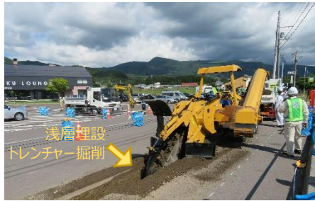
写真-4 「道の駅」前面の国道で行われた電線共同溝事業（七飯町）。寒冷地における浅層埋設やトレンチ掘削を実施した
