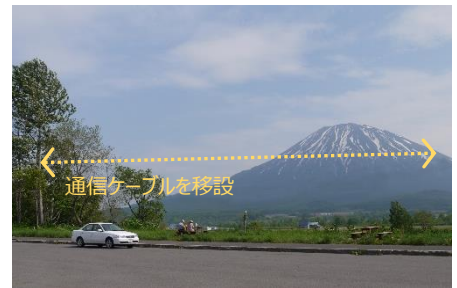
写真-3 羊蹄山を眺めるビューポイントパーキング（倶知安町）。通信柱とケーブルを眺望を妨げないように移設した
