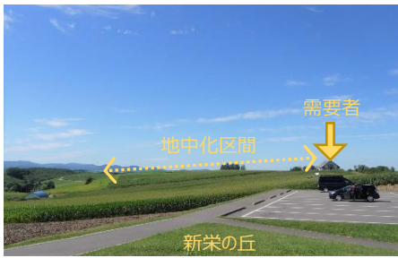
写真-1 新栄の丘展望台付近の地中化（美瑛町）。ビューポイントから近傍町道の電線電柱類を見えなくするため地中化を実施
