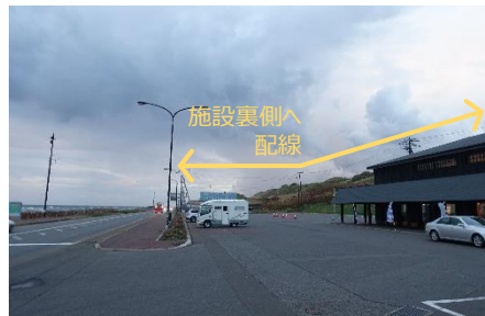
写真-2 「道の駅」前面道路の無電柱化（小平町）。施設裏側に電線電柱を配線し、施設への眺望や施設前の日本海の眺望を向上させた
