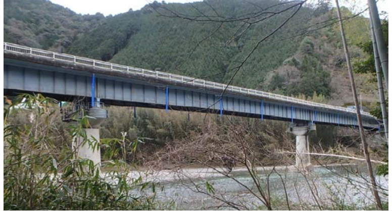
写真1. 錦橋（撮影；著者，2022年）
