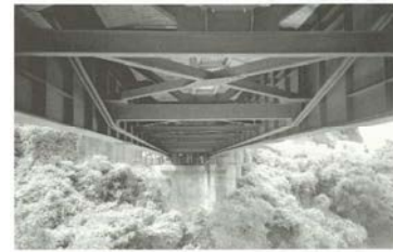
写真 2. 外ケーブル偏向部横梁の全景(錦橋) 2)
