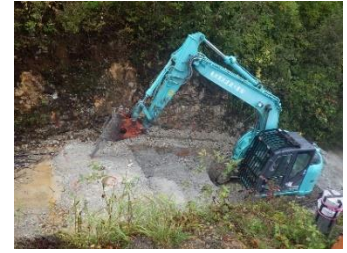
写真-2 固定台解体状況
