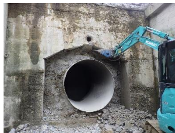
写真-5 埋設部解体状況
