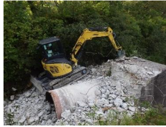
写真-2 固定台解体状況
