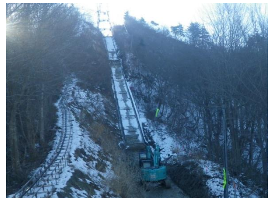
写真-7 固定台・小支台解体完了
