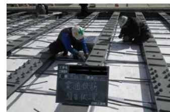
写真-1 配筋作業
