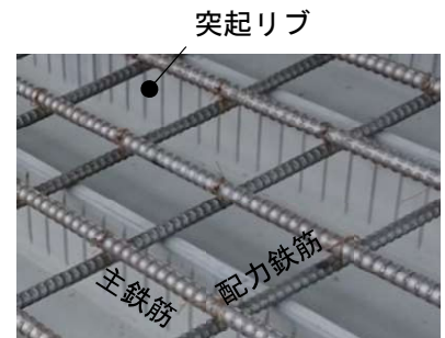
写真-1 突起リブを用いた合成床版
