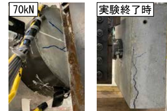
写真-1 せん断試験体 損傷状態
