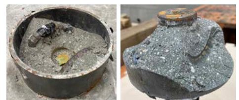
写真-2 引抜き試験体 損傷状態
