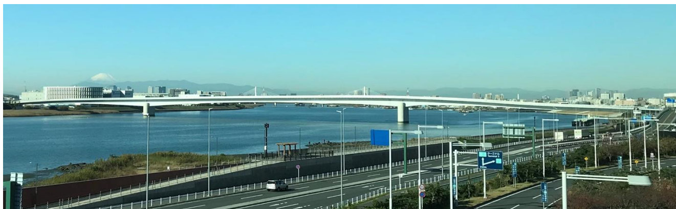
図-1 2022年3月12日に開通した多摩川スカイブリッジ 3径間連続鋼床版箱桁複合ラーメン橋
